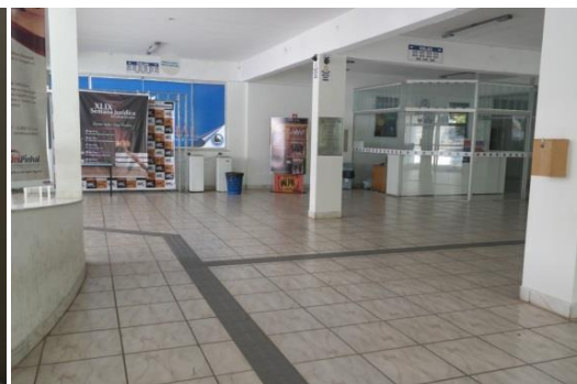
Figura 4. Instalação de piso tátil
