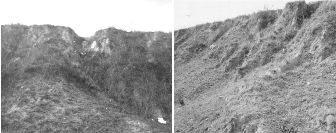
**Figuras 5.** Processos erosivos ativos (sulcos e voçorocas) comprometendo a infra-estrutura ao longo de todo o açude. Coordenadas: 7°12'51,7"S e 35°54'39,7"W (Foto de julho de 2007).
