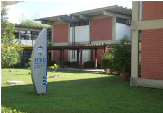
Figura 2: Fachada do Instituto de Tecnologia da UFPA
