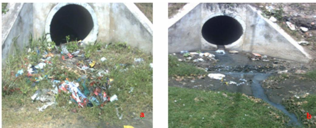
**Figura 6.** Galerias pluviais com escoamento de esgoto e resíduos sólidos de diversas origens (industrial e doméstico) em vários pontos, ao longo do açude Bodocongó (Fonte: Carvalho, 2007).
