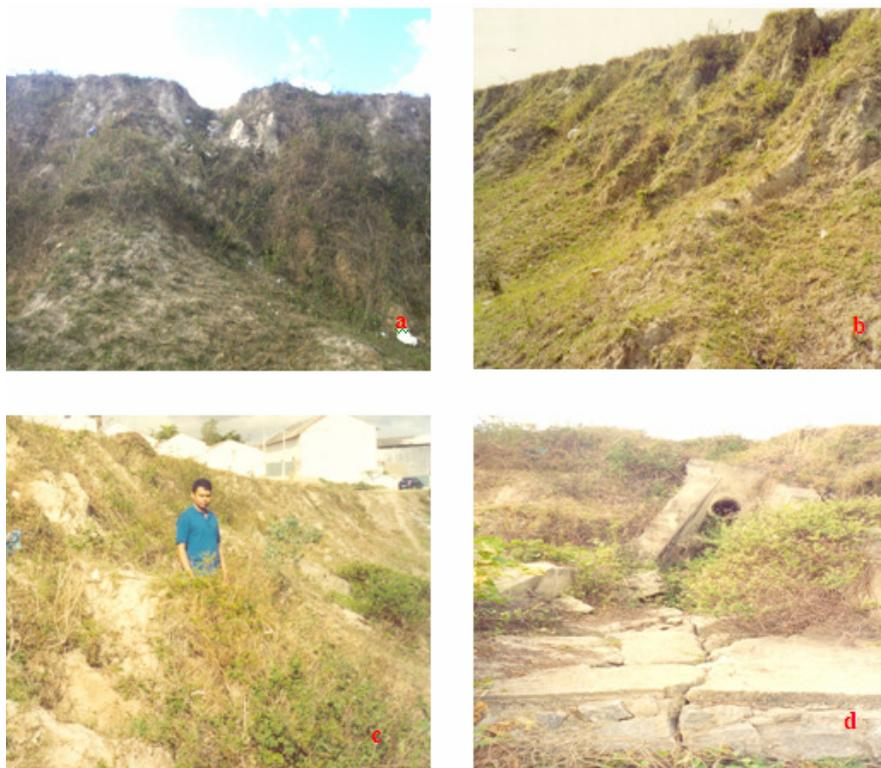
**Figura 2.** Processos erosivos ativos (sulcos e voçorocas) comprometendo a infra-estrutura ao longo de todo o açude (Fonte: Carvalho, 2007).
