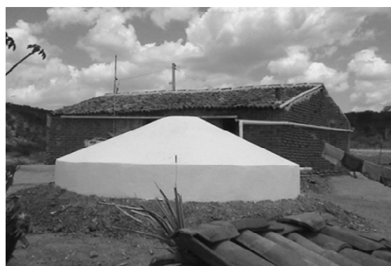
Figuras 4. Cisternas de placas pré-moldadas, modelo PIMC. Fonte: Pesquisa de campo, 2008
