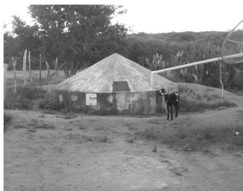
Figuras 4. Cisternas de placas pré-moldadas, modelo PIMC. Fonte: Pesquisa de campo, 2008
