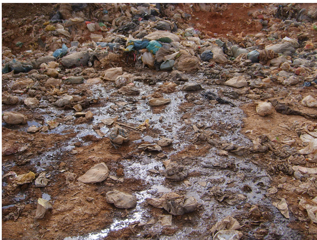
Figura 6. Escorrimento de chorume no aterro de Andradas - MG, em maio de 2008. (Foto: Alcides Pedro de Souza Junior)
