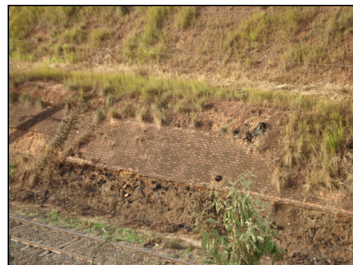
Figura 5. Detalhe de muro de arrimo para contenção de talude.
