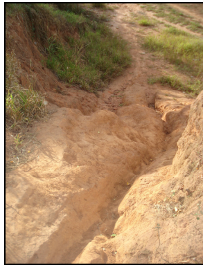
Figura 2. Detalhe de sulcos erosivo (RC-2)
