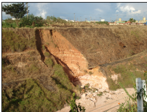
Figura 4. Escorregamento circular afetando a linha férrea
