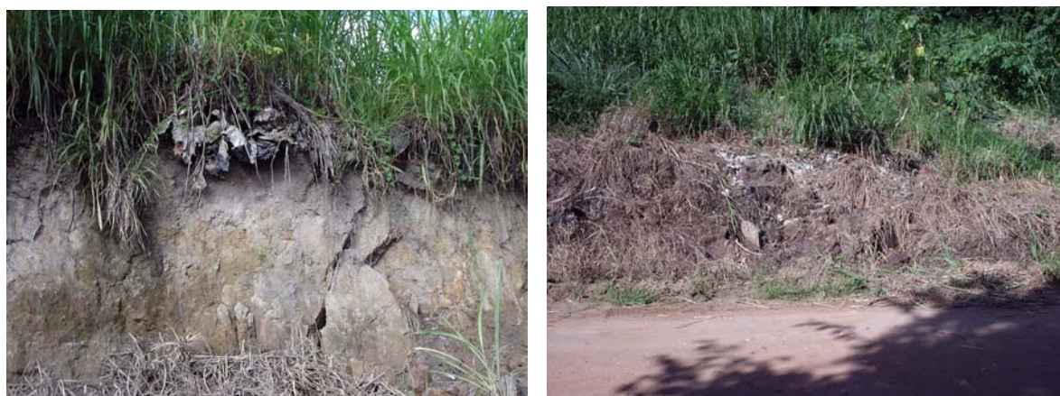
Figura 4. Barranco na beira da estrada de rodagem (esquerda) e foto da estrada (direita), ao lado do lixão, no qual observa-se o afloramento de lixo (Fotos tiradas por Euzébio Beli em março de 2004).
