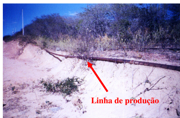
Figura 4 – Linha de produção ao longo de uma estrada da área em situação de risco.
