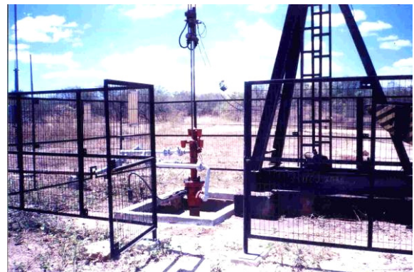
Figura 18 – Detalhe da estrutura de segurança do poço.
