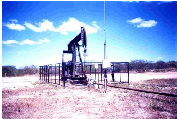
Figura 17 – Poço que aparentemente está dentro das normas de segurança.
