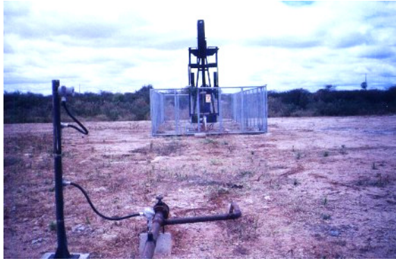
Figura 15 – Poço CAM-197. Avanço do processo erosivo, pela erosão laminar e por sulcos incipientes.
