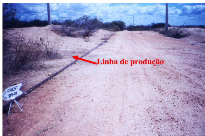
Figura 6 – Risco das linhas de produção depositadas diretamente sobre o solo. Ponto próximo ao poço CAM-490 (x = 699.207 ; y = 9.431.611)
