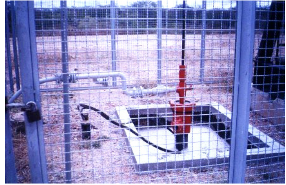
Figura 16 – Poço CAM - 197. Detalhe da estrutura de segurança do poço. Nota-se que o portão está trancado por um cadeado. A cisterna está limpa e a estrutura está bem conservada.
