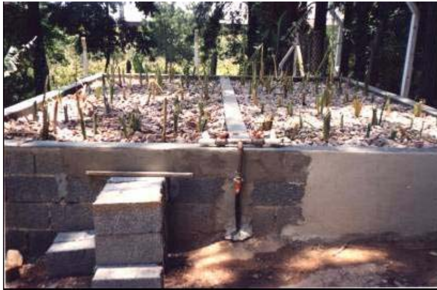
Figura 3. Mudanças de Typha sp. plantadas nos leitos cultivados instalados na saída da estação de tratamento de esgoto (ETE), no ano de 2001.
