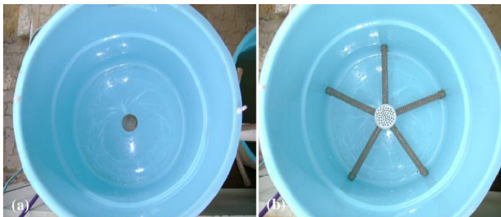
Figura 1 – (a) Vista superior da caixa de 250 litros com seu furo adaptado de 100 mm e (b) canos coletores de água acoplados em uma luva de 100 mm de diâmetro no fundo da caixa.
