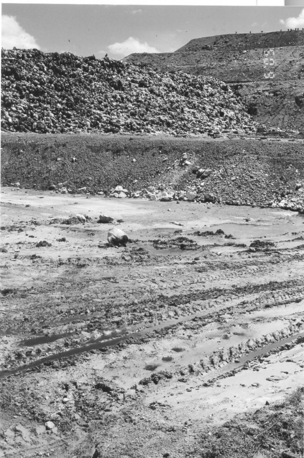
Figura 3. Escorrimento superficial do chorume junto ao aterro sanitário do município de Cuiabá - MT. (Foto tirada por França Filho, em junho de 2006).
