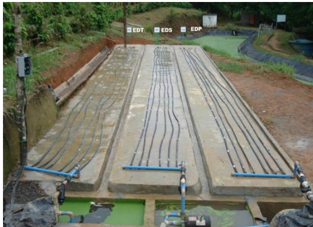
Figura 2. Módulos experimentais destacando-se os reservatórios com esgoto sanitário após tratamento preliminar (ESP), secundário (ESS) e terciário (EST), conjuntos motobomba, filtros de discos e válvulas reguladoras de pressão.
