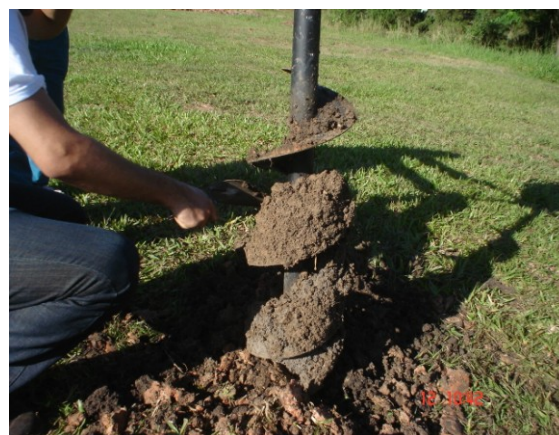
Figura 1 – Utilização do trado mecânico para construção dos poços de monitoramento.
