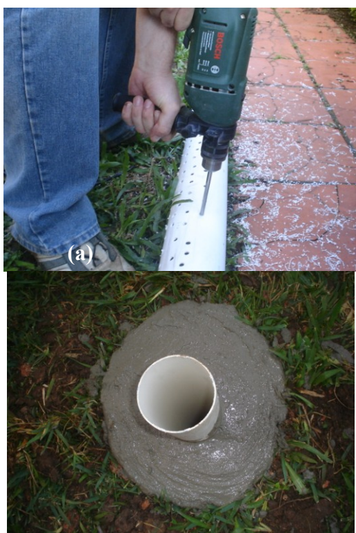
Figura2 – Construção do filtro, pré-filtro e selo sanitário.
