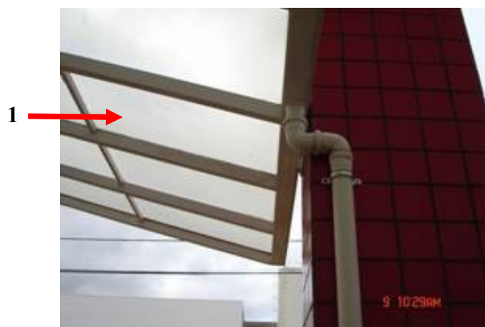
Figura 3. Telhado da Fábrica Grafimec (Ponto de Coleta 1).
