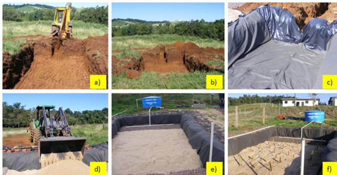
Figura 2 - Detalhes da construção do FPMH. a) escavação; b) filtro escavado; c) detalhe da impermeabilização; d) assentamento do material filtrante; e) detalhamento das zonas de entrada e saída preenchidas com brita; f) filtro com as macrófitas recém plantadas.
