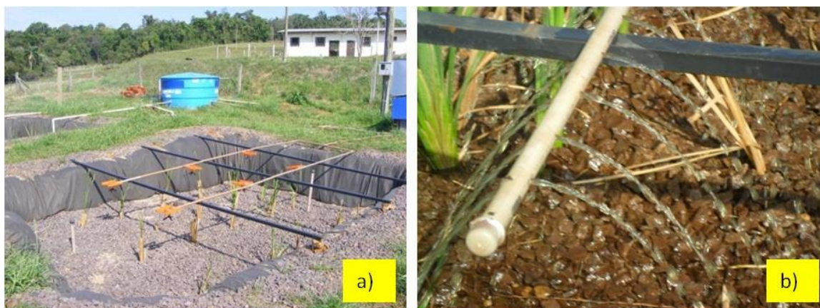
Figura 3 – Alimentação FPMV; a) detalhe da tubulação de alimentação; b) detalhe da alimentação do FPMV.
