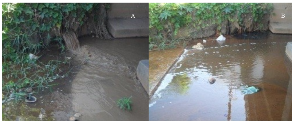
Figura 2. Despejo de esgoto doméstico e industrial (A) e resíduos sólidos (B) lançados no Riacho Agon, nas imediações da Avenida Ministro José de Américo, centro de Catolé do Rocha – PB.
