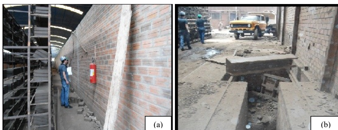
Figura 8. (a) Local de difícil acesso e falta de sinalização no extintor de incêndio, (b) Local de possível risco de queda sem sinalização.
