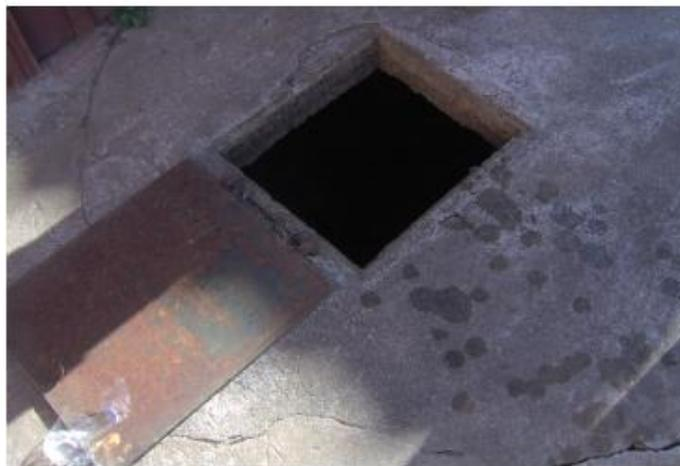
**Figura 4** - Poço escavado no nível do terreno sem vedação adequada apresentando risco potencial de contaminação, Santa Maria - RS (2008).
