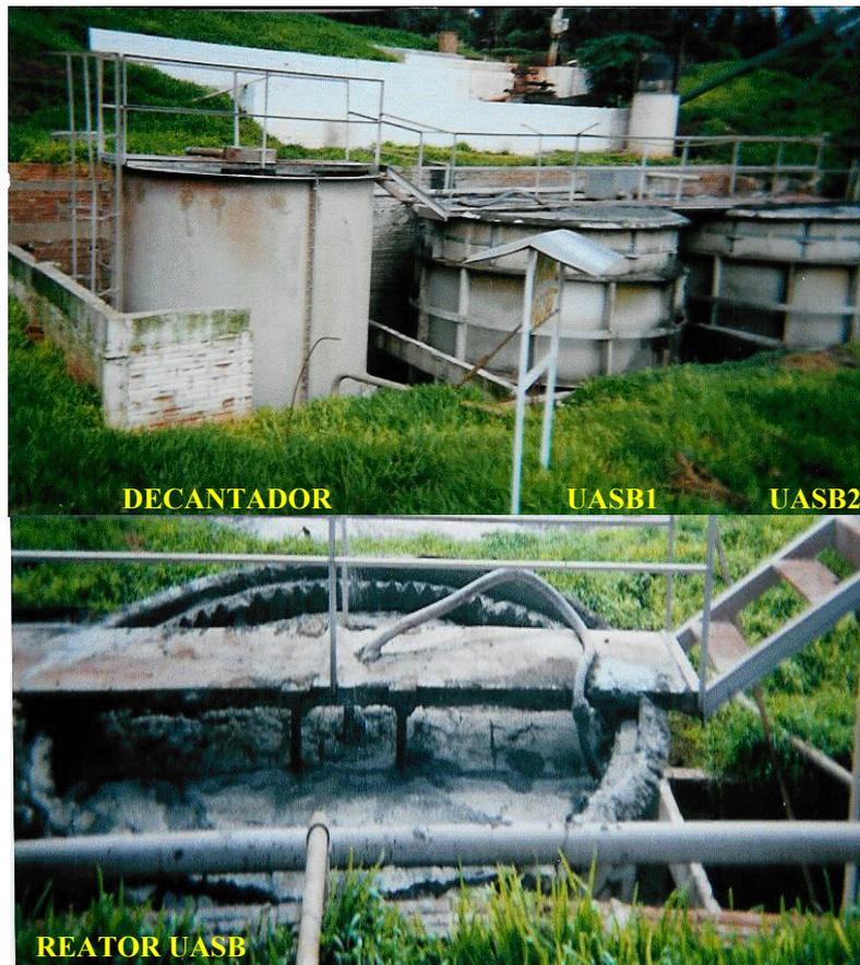
**Figura 4.** Decantação (decantador primário) e tratamento secundário (UASB1 e UASB2) (foto superior). Vista superior do reator UASB1 (foto inferior). (Fotos tiradas por Marlise Schoenhals em 26/05/03).
